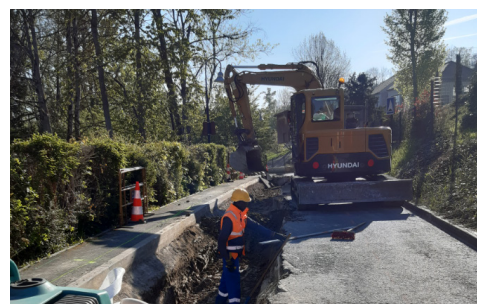
Travaux de voirie
